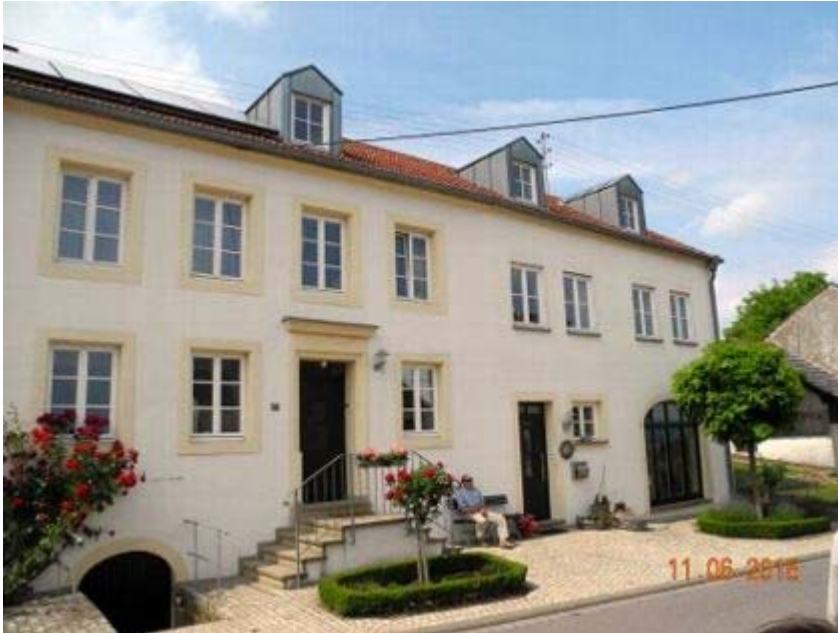
Bildunterschrift: Haus im Stadtteil Kahren
